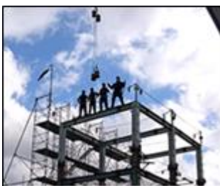
鉄骨建て方作業で、鉄骨上での作業
